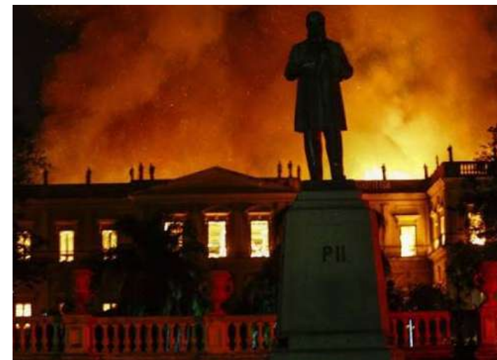
Estrutura das instalações era muito antiga e facilitou a propagação das chamas
